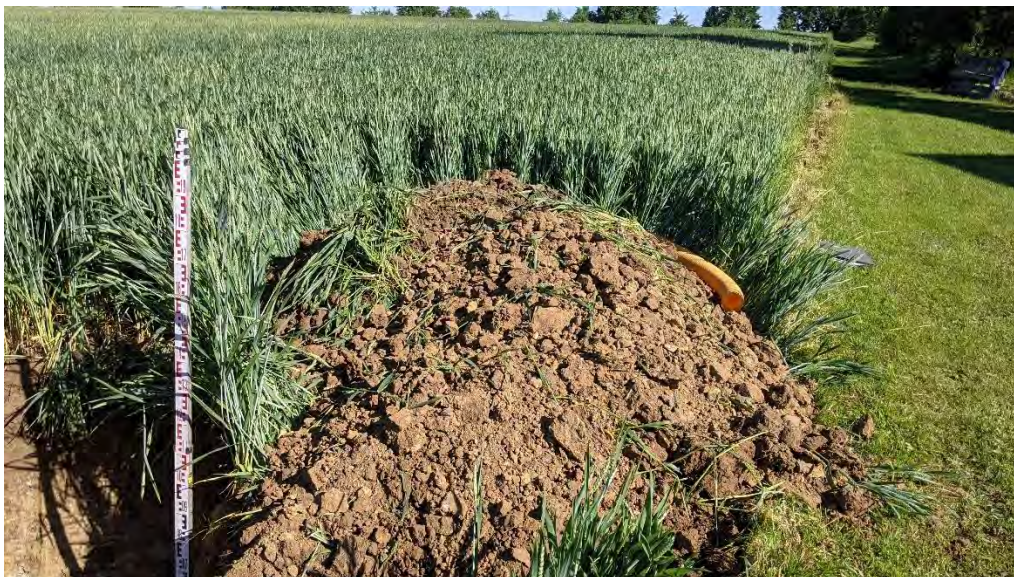
Bild 11: Baggeraushub aus Schurf S2 – V2.
