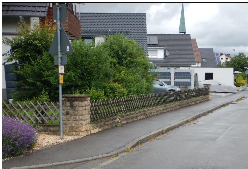
Abbildung 5-4 Mauer „Im Wiesengrund“
