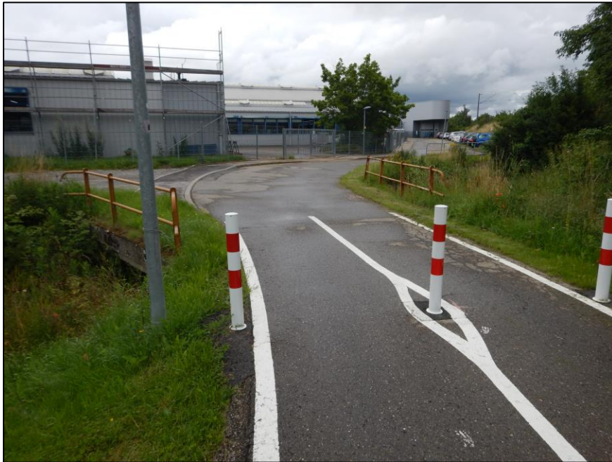
Abbildung 5-5 Brücke „Alte Gärtringer Straße“
