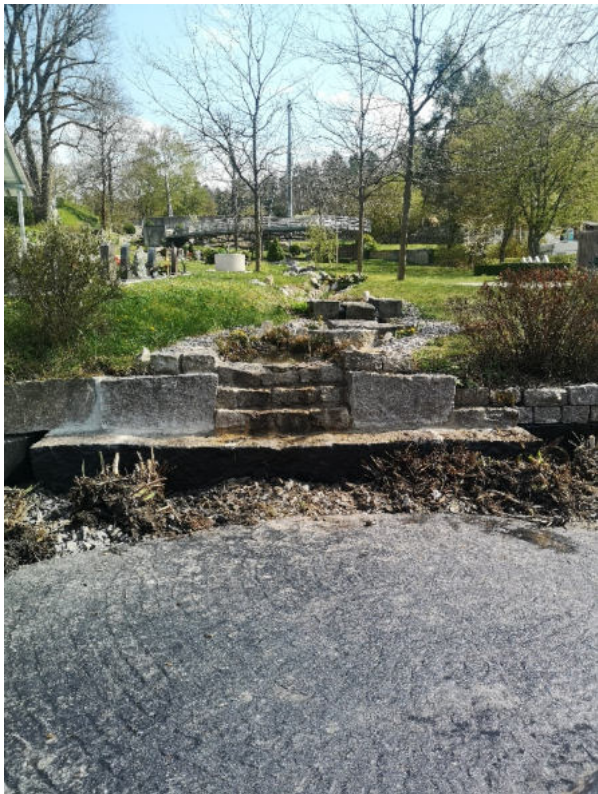
Bachlauf im Friedhof abgedichtet.
