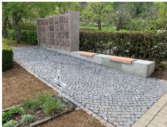
Pflasterfläche vor neuer Urnenwand hergestellt
